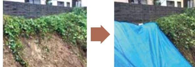
崖崩れには、ブルーシート・土のう・鉄筋棒などによる応急処置を行っています。
